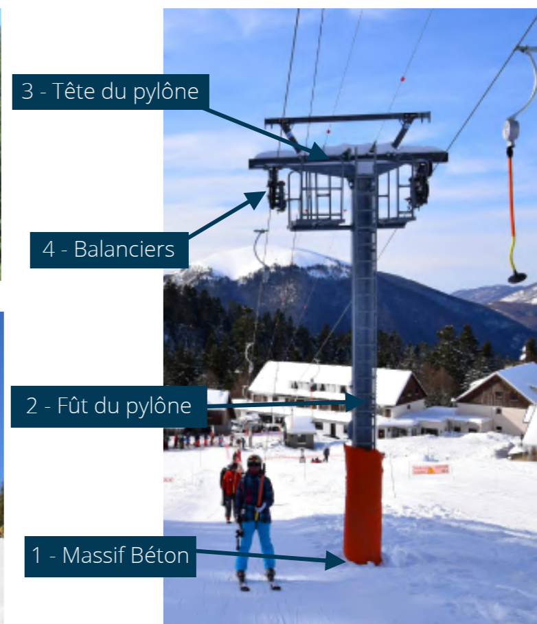
Ci-dessus, Pylône T incliné. Dessous T classique
