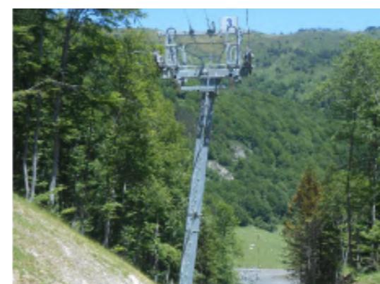
Ci-dessus, Pylône T incliné. Dessous T classique
