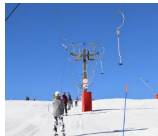
Ci-dessus, Pylône T incliné. Dessous T classique
